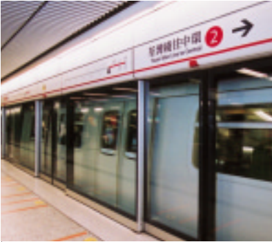
二月於尖沙咀站的新月台幕門
