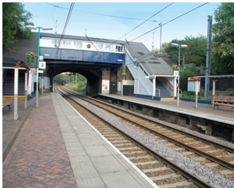
London Overground聯繫倫敦西部、北部及東部。
