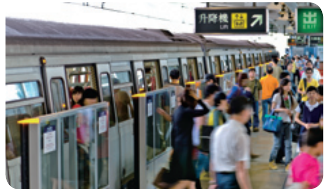
新的月台自動閘門，改善月台情況
