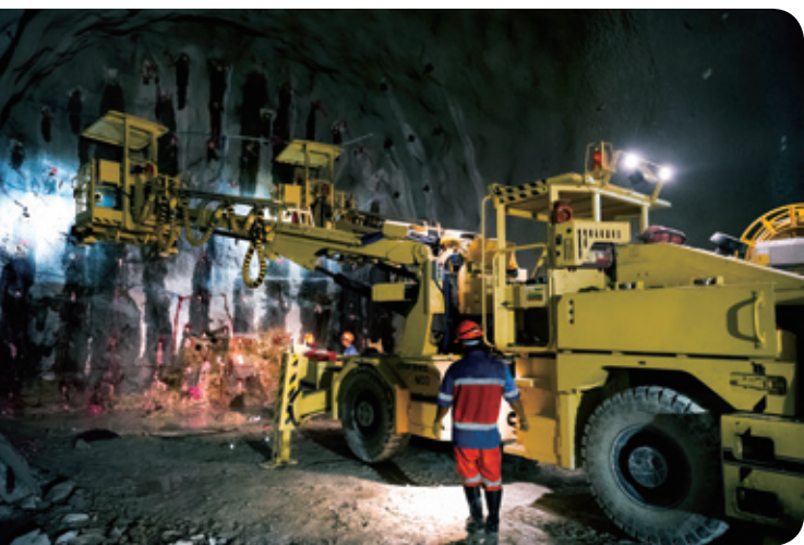
高鐵香港段的列車隧道已有大型隧道挖土機投入運作以爆破方法進行挖掘
