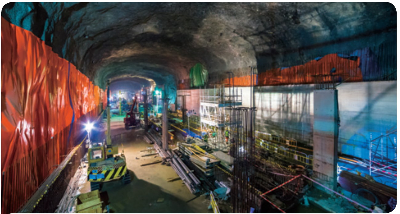
香港鐵路拓展項目的隧道挖掘工程正全速進行
