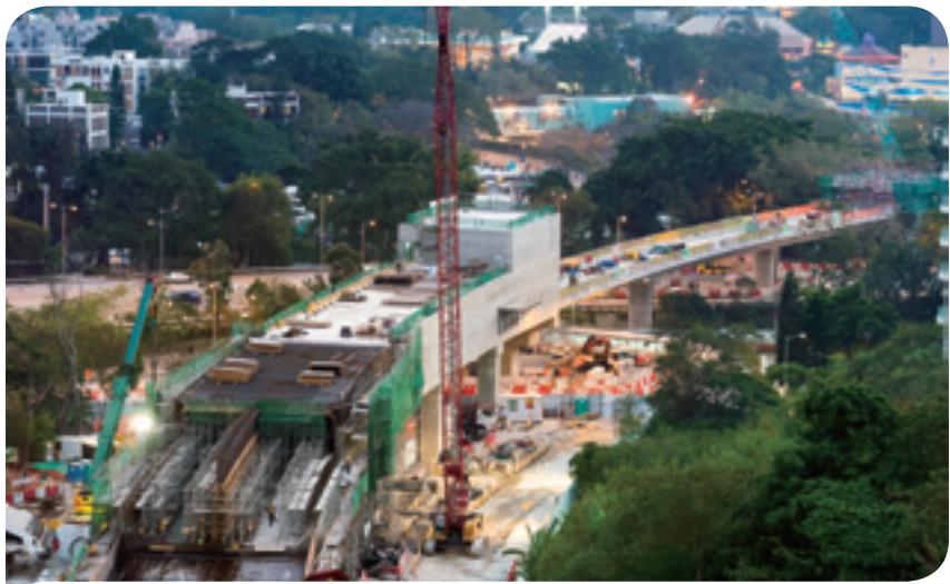
橫跨港島南區的高架橋工程
