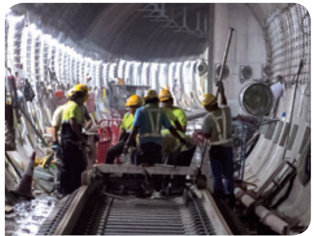
西港島綫的隧道路軌鋪設工程已展開
