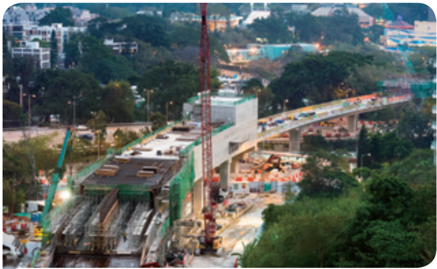
橫跨港島南區的高架橋工程
