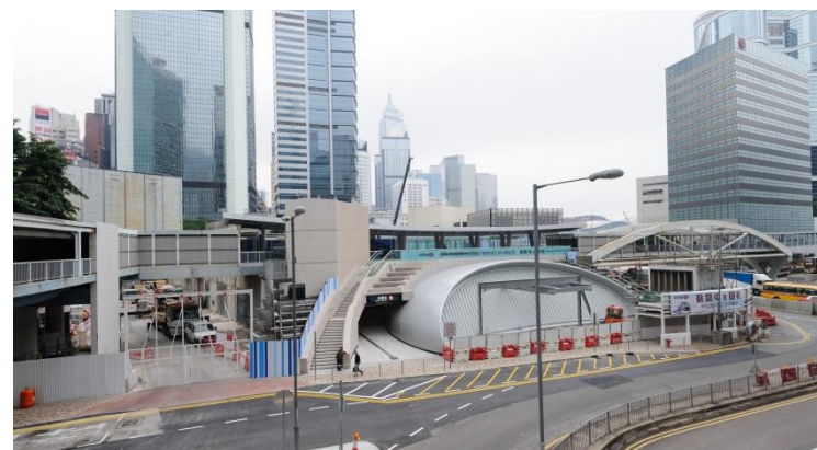
沙中綫於金鐘站的出入口
