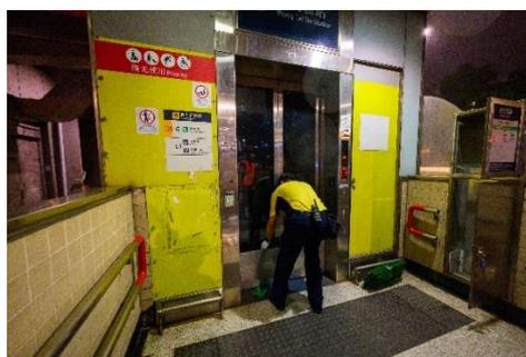
4. 因應黃大仙站 B3 出入口的獨特地理環境，港鐵公司於該處現有的防水門外加設防洪板，有助阻隔洪水中的障礙物妨礙職員關上防水門，並會在該處試驗再加裝一套自動防洪板的可行性及效用。
