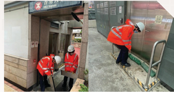
(左) 車務部同事於車站加裝防洪板； (右) 車務部同事於車站外放置沙包，以防雨水沖入
