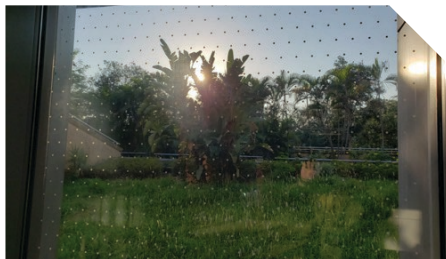
(上) 在車站轉乘通道的窗戶上貼了一組雀鳥圖案的貼紙 (下) 為美孚站逾 100 幅玻璃幕牆張貼防鳥撞窗貼紙
