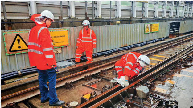
港鐵員工於超強颱風「樺加沙」吹襲後執行設施維護工作
